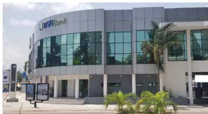
Siège BGFI Bank Brazzaville
